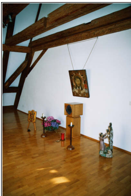
Ebenfalls offengelegter, sanierter Dachstuhl im Gebetsraum des Carceri-Konventes;
