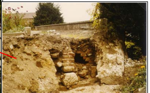
Bei Sanierungsarbeiten an der Südwestecke des „Hofgartens“ vorgefundene Fundamentreste der inneren Mauer des alten Klostergebäudes;
