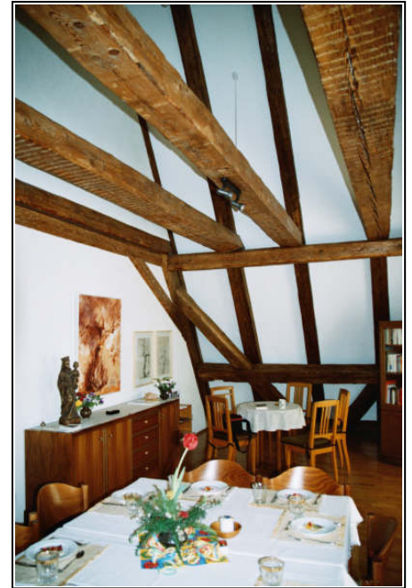
Offen gelegter Dachstuhl im Ess- und Aufenthaltsraum des Carceri-Konventes – der „Preis“ hierfür sind sicher höhere Energiekosten für die Heizung;
