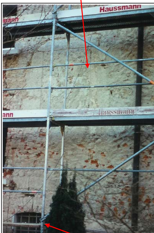
Zugemauerter Kryptazugang von außen mit Restbestand eines kleineren vergitterten Kellerfensters;
