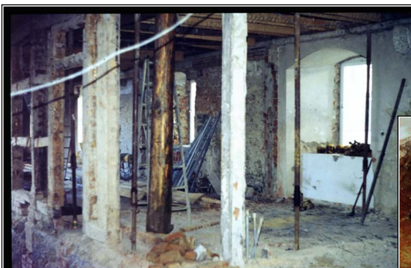
Freilegung des Ziegelsteinbodens unter einer Beton-Estrich-Schicht;
