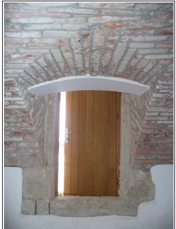
Die Zugangstreppe innen wurde nicht mehr restauriert, da sie keinen Zweck mehr erfüllt;
